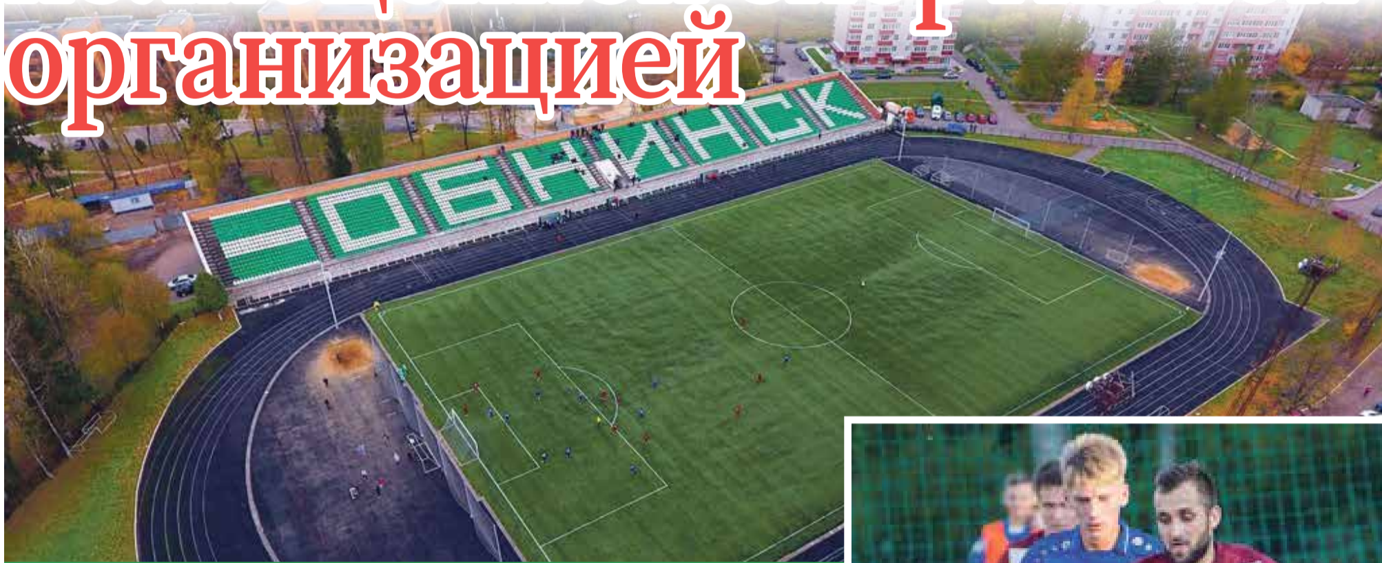
Не только трибуны на стадионе «Труд», но и весь стадион нуждаются в обновлении
