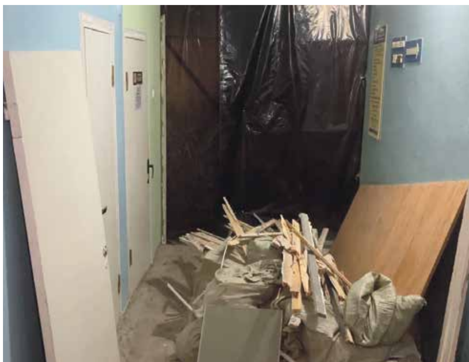
В КБ № 8 всюду ведутся ремонтные работы
