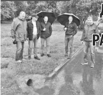
Комиссия по контролю содержания и ремонта дорог провела осмотр ливневой канализации на магистральных дорогах Обнинска.
