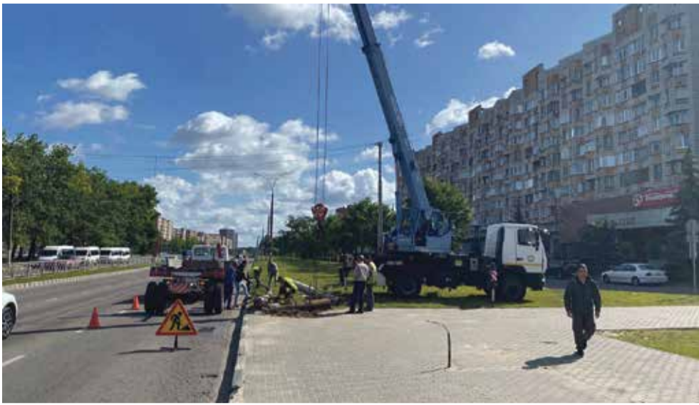
■ Работы по восстановлению поврежденной в ходе ДТП опоры освещения на проспекте Маркса
