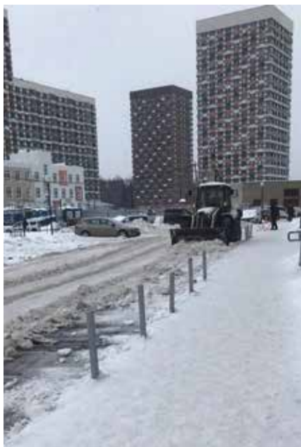
■ Расчищенный внутридворовый проезд
