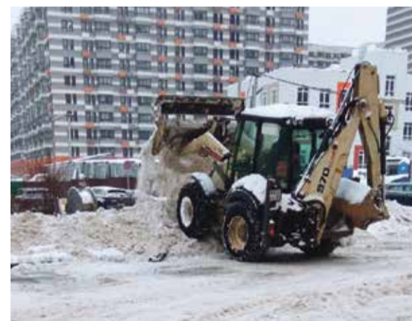
■ На уборку дворов рабочие УК ГК Жилищник выходят в 6 утра
