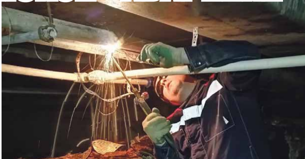
■ Работа электрика - дело тонкое
