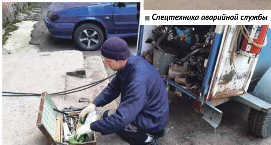
■ Сварочный пост АДС задействован ежедневно
