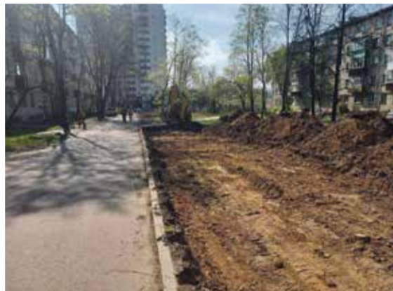
■ Работы по программе благоустройства ТОСов
