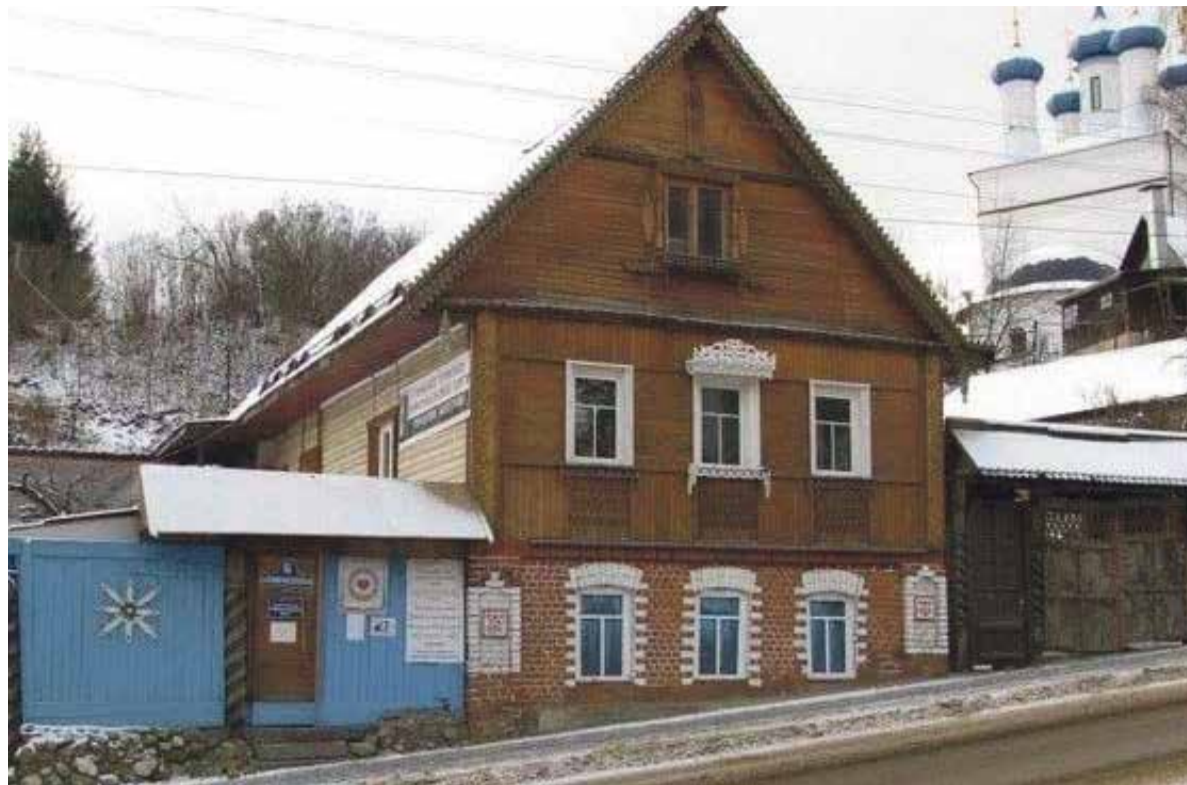
■ Дом на ул. Калужской с изменённой фирмой крыши и надстроенной мансардой.
