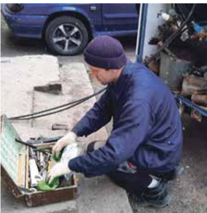
■ ВМ Аварийка Работает сварочный пост
