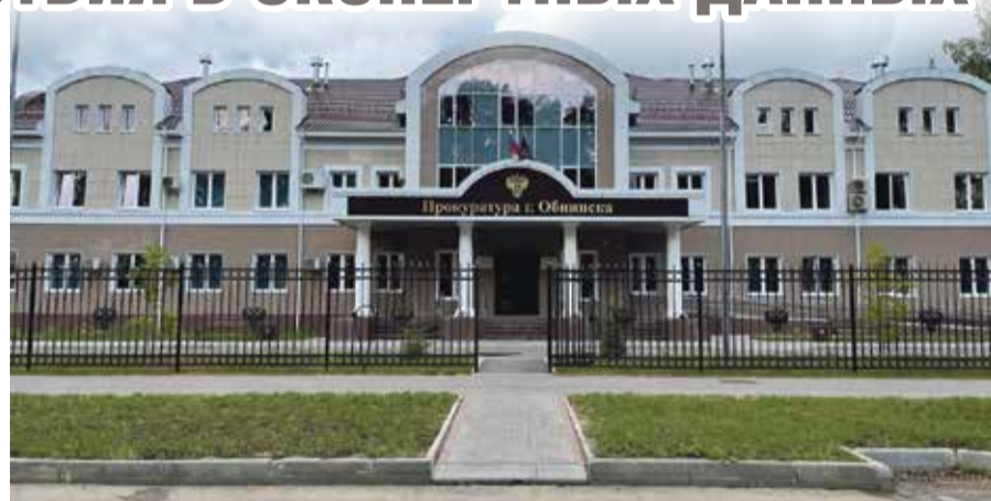
■ Прокуратурой города Обнинска были обнаружены нарушения в работе оборудования
