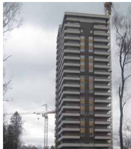
■ Строительство нового дома на Кутузова, который пока стал единственным, куда переселили жителей Мирного
