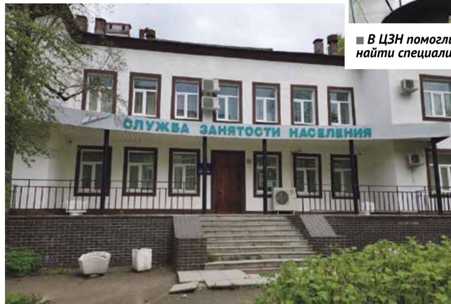
■ Здание обнинского Центра занятости
