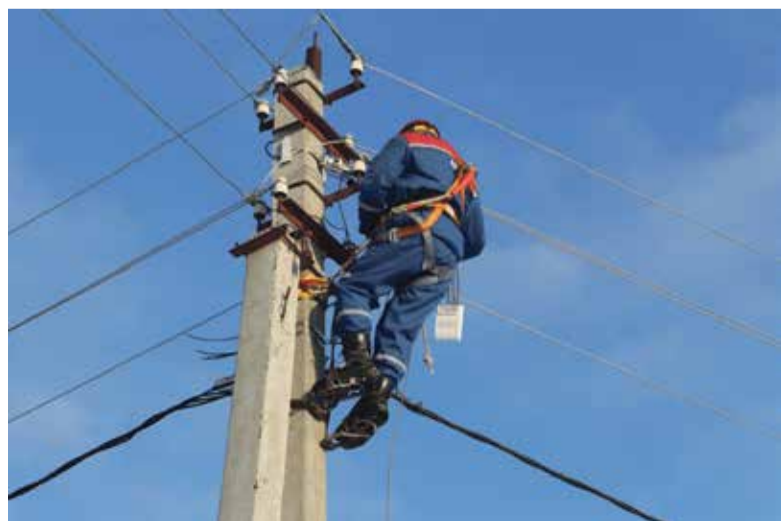
■ Ремонтные работы на сетях тоже доставляют жителям неудобства
