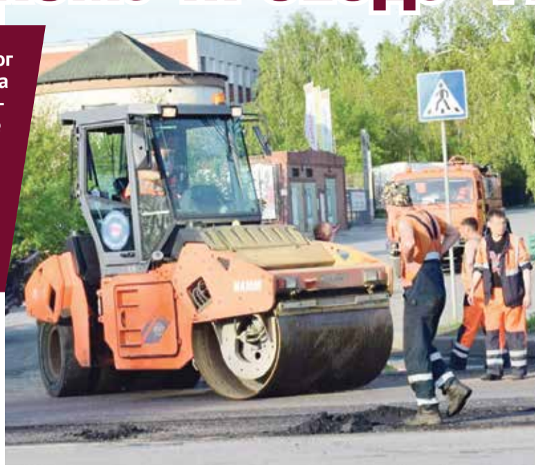
■ На ремонт дорог по контракту дается два месяца
