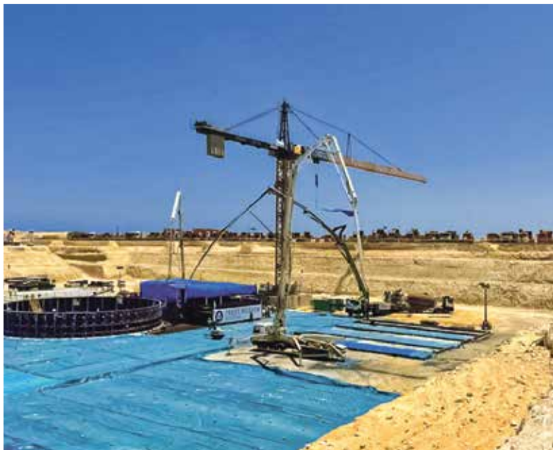
■ Залит первый бетон в основании АЭС в Египте
