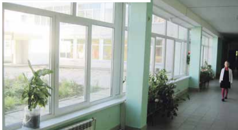
■ Новые окна в десятой школе установили в ходе второго этапа капремонта
