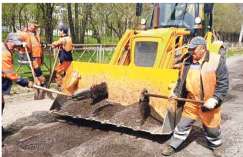
■ Работы по ямочному ремонту
