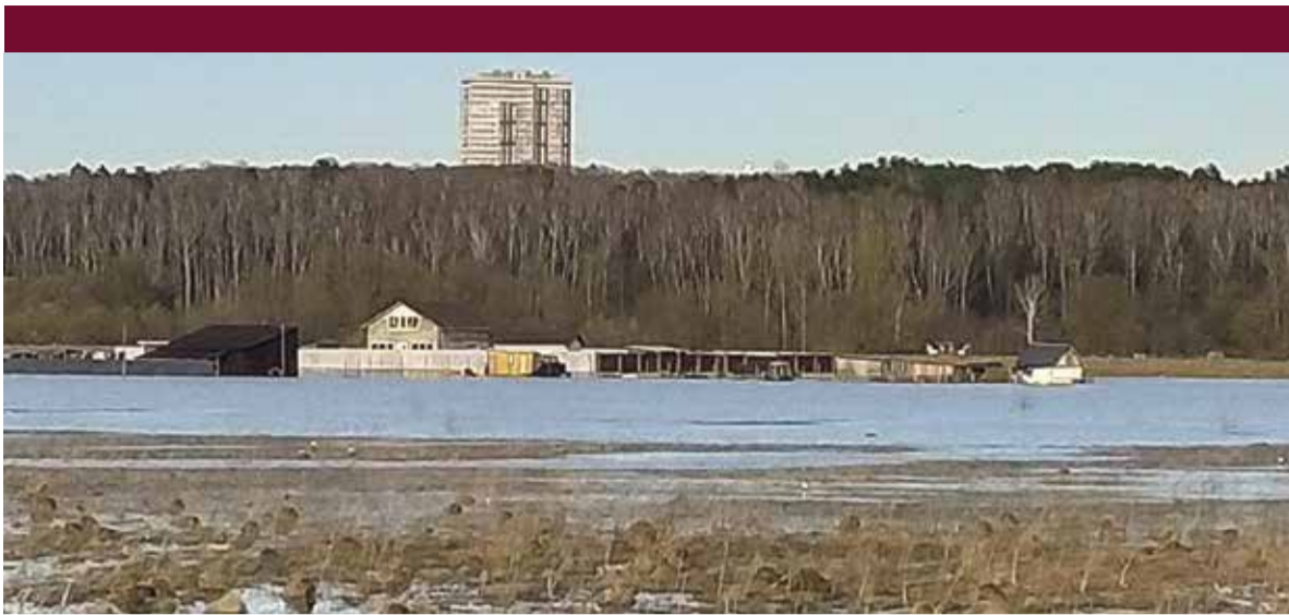
■ Дома стоят практически впритык к плотине
