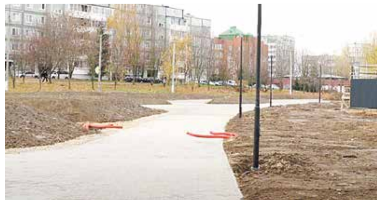
■ Работы по благоустройству территории у Белкинского парка закончат следующей весной
