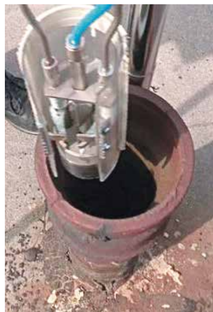
■ Установка заглушки на водоотведение
