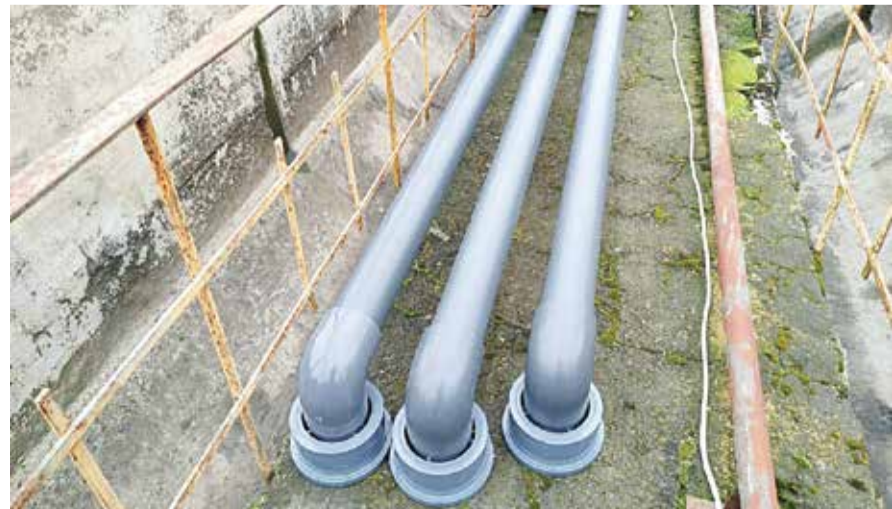
■ Ведется реконструкция одной из секций первой технологической линии очистных сооружений
