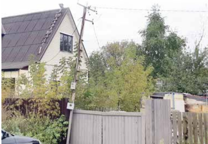
■ Провисшие провода становятся причиной аварий
