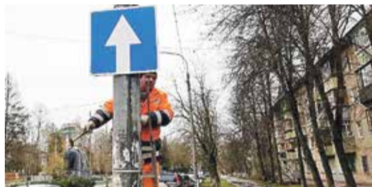
■ Установка дорожного знака в районе подлочки
