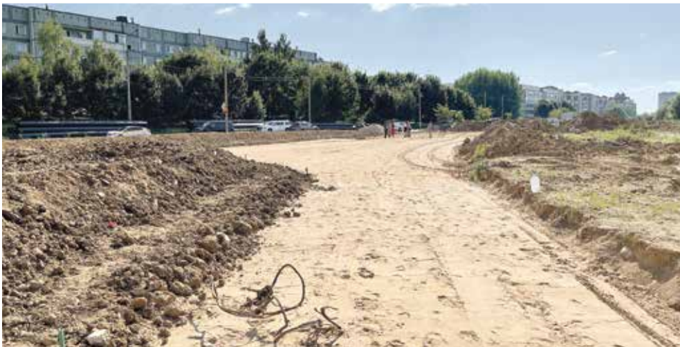
■ Дорожка подготовлена к укладке геотекстиля
