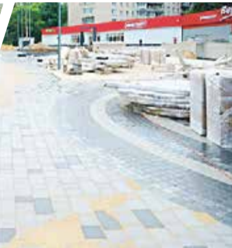
■ На Курчатова, 13 завершают укладку плитки
