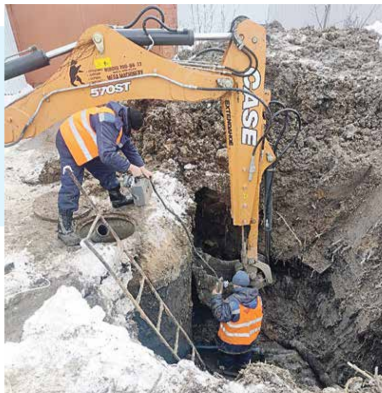
■ Работники МП «Водоканал» трудятся на одной из улиц города
