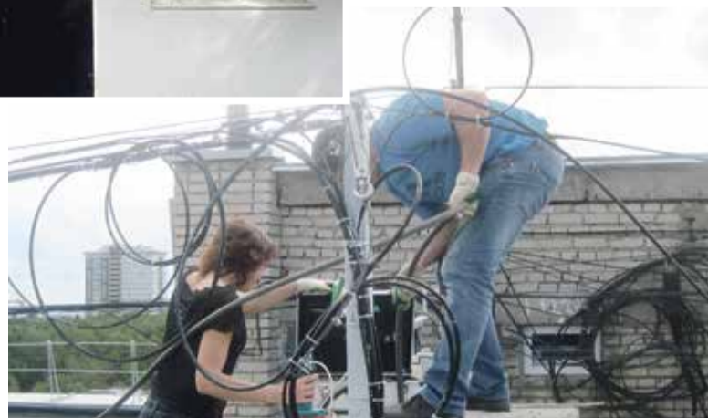
■ Установка заглушки в одной из многоэтажек Обнинска
