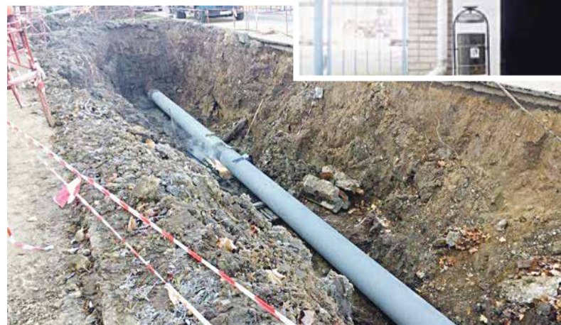
■ Замена водопроводных труб
