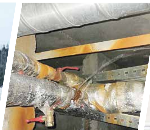
■ Переборка сгонов отопления на Поленова, 6
