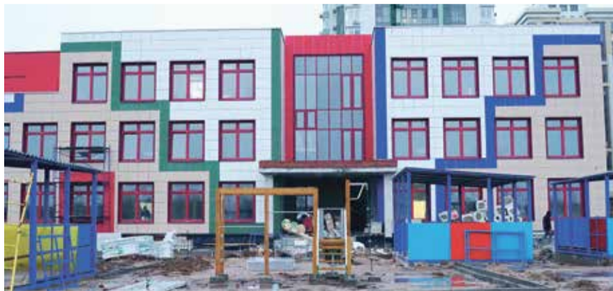
■ Детский сад на 150 мест в микрорайоне «Солнечная долина». В данное время ведутся работы по благоустройству территории и установке малых архитектурных форм. Производится монтаж индивидуального теплового пункта и водомерного узла, систем вентиляции и электроснабжения. Также ведётся работа по устройству входных групп и запасных выходов. Продолжаются отделочные работы внутри здания, а также подготовка чаши бассейна и гидравлические испытания.
